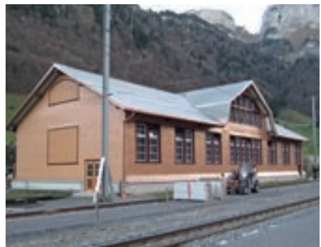
Depot der Appenzeller Bahnen in Wasserauen
