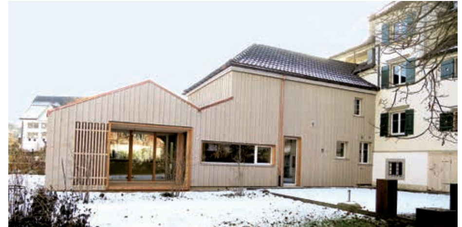
Der Schopf des renovierten Fabrikantenhauses erhielt auf der Rückseite einen Anbau, der die Formensprache der Anbauten auf der Gartenseite der Steinfelsstrasse in Ebnat-Kappel aufnimmt.
