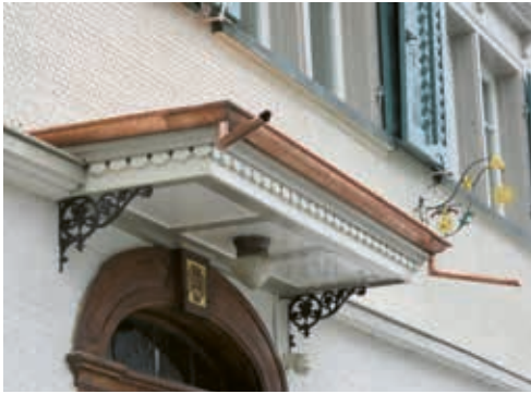
Die Fassaden wurden sanft saniert, mit Mineral- und Oelfarben gestrichen und so zeigt sich das Haus in neuem Glanz. Alle Details sind liebevoll restauriert und erhalten geblieben.
